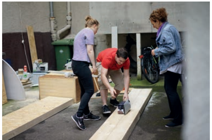
Abb. 15: Eindrücke vom Aufbau
