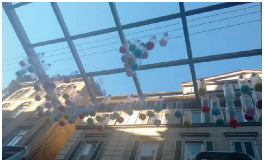
Abb. 94: ... und an der Deckenkonstruktion befestigt...
